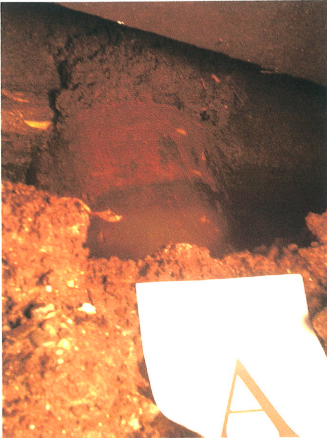
Foto 4: Paal A. Wat veen kleeft aan de paalkop.
