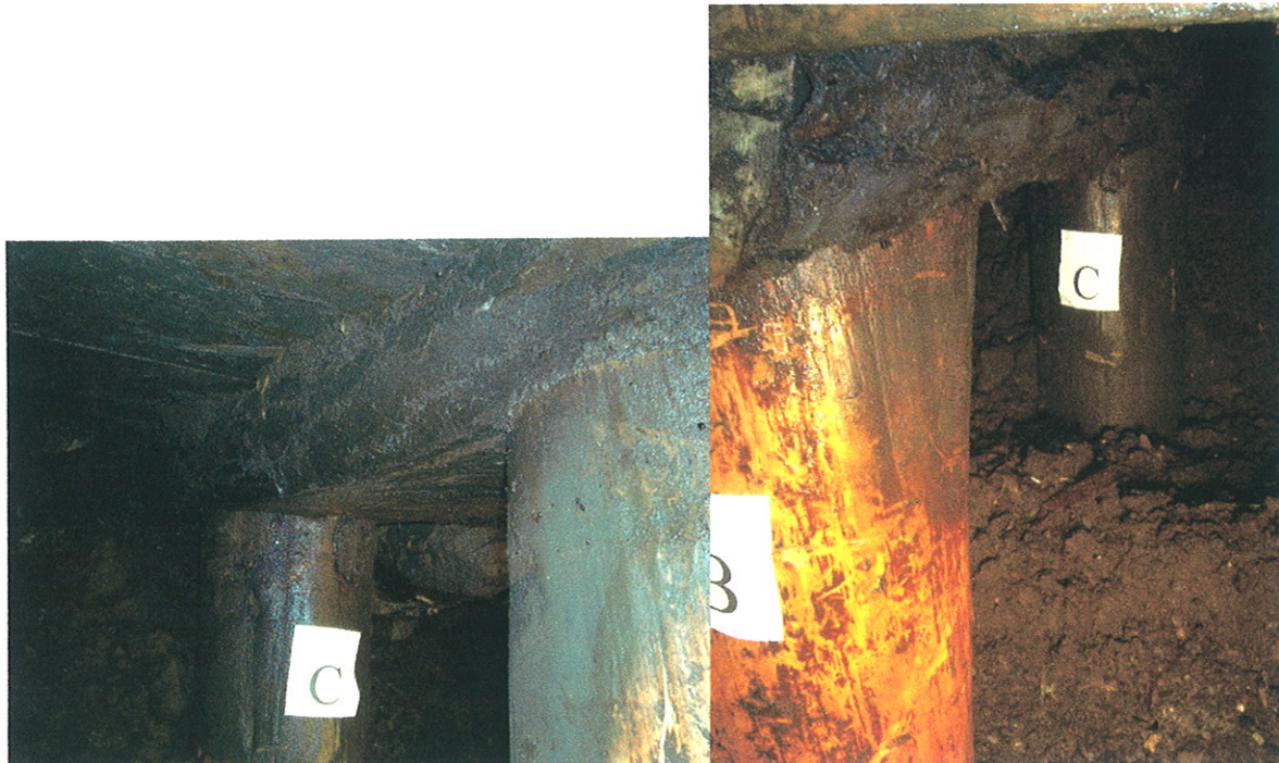
Foto's 5 en 6: Kesp K2 boven palen C en B gezien vanaf beide kanten.
